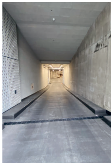
Einfahrt zur Anlieferung, welche Teil des Logistiktunnels ist.
