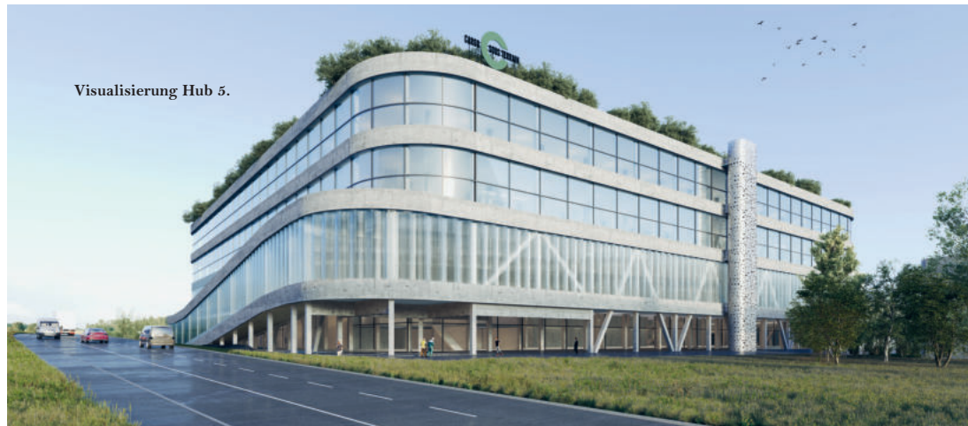
© Cargo sous terrain AG, www.cst.ch
