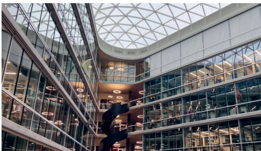
Das Atrium des D-BSSE mit einer natürlichen Rauch- und Wärmeabzugsanlage und der Fassade EI30, nicht öffnbar.
